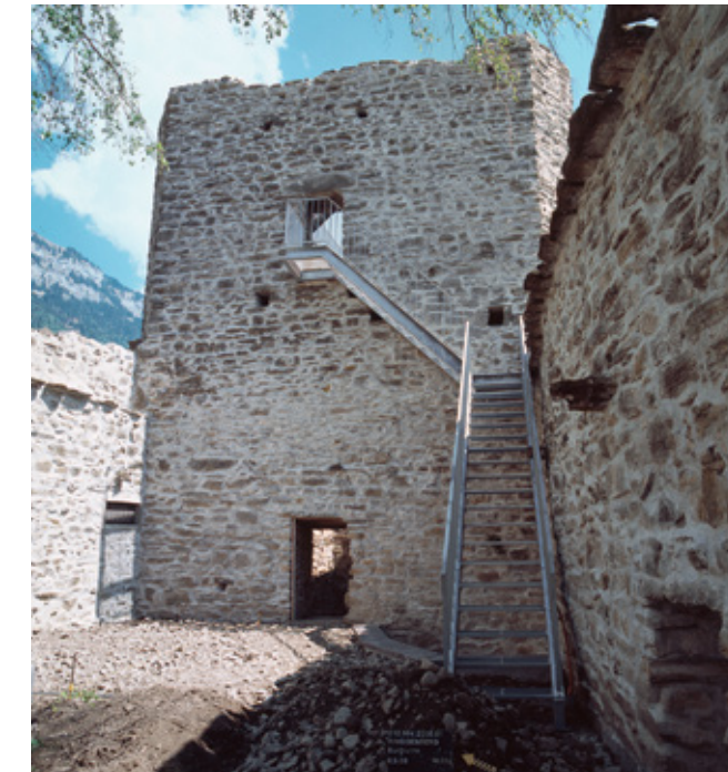
Burghof mit der Fassade des Ostturms. Anstelle des alten Aufgangs führen heute Metalltreppen zum Hocheingang des Festsaals. Der untere Zugang ist neuzeitlich.
